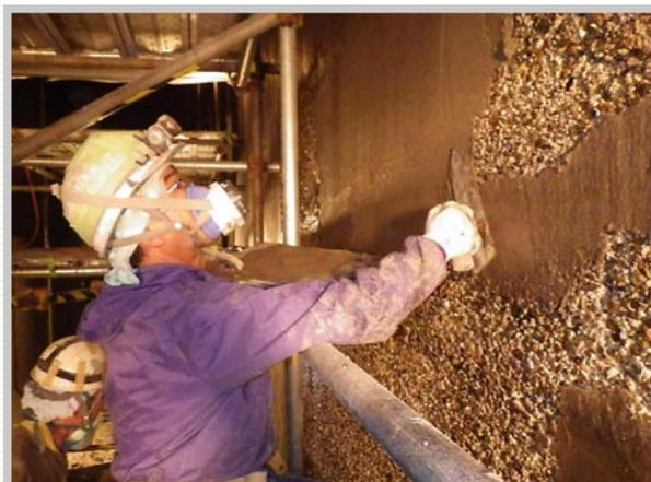
ポリマーセメントモルタルにて劣化部除去後の断面修復を行います。躯体表面を緻密で平滑になるように仕上げます。施工後は十分に乾燥させてから次工程に移ります。
