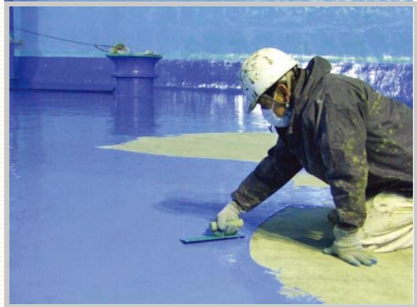
素地調整兼プライマーは塗膜が均一になるように塗布します。材料は指定の混合比にて調合し、ローラー、コテ、ヘラなどで空隙が無いように押さえて塗布します。指触乾燥確認した後、次工程に移ります。
