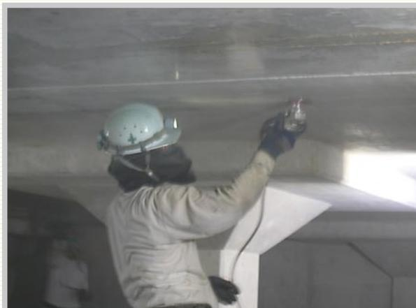
超高圧洗浄やサンダーケレンにて躯体表面の劣化部や脆弱部を除去します。除去後、漏水・ジャンカ・クラックなどの欠損部や中性化している箇所が無いことを確認してから次工程に移ります。欠損箇所があった場合には適切な処理を行って下さい。
