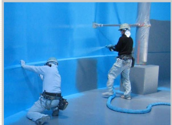
ポリウレア樹脂を専用スプレー機械にて塗布します。スプレーは熟練した作業員が行いますので均一な塗膜が形成されます。硬化時間は10秒程度ですので、天井面、壁面でも容易に施工が可能です。
